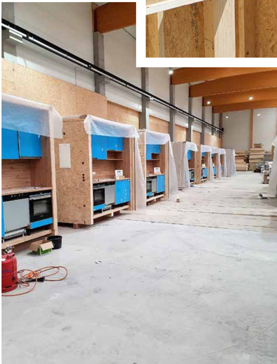
Fertige Bad- und Küchenmodule mit tragender Funktion, Foto Dirk Heidschuster
