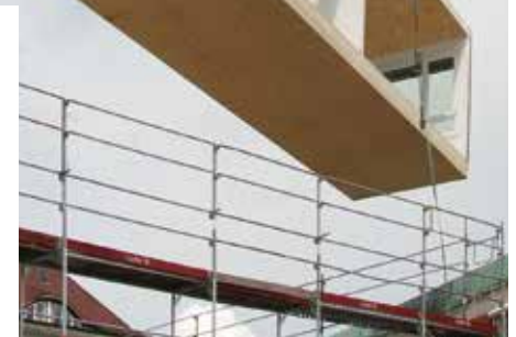
Modulbauweise, Foto rosengruen.de
